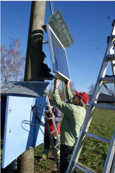
Pius musste eine zusätzliche Konstruktion erfinden, damit das Solarpanel wie bisher nach Süden zeigt.
